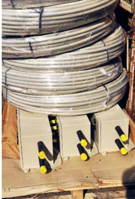
Anschlussrohre und die drei Verteiler für je zwölf Glykolkreise für das Bauvorhaben Markgröningen
