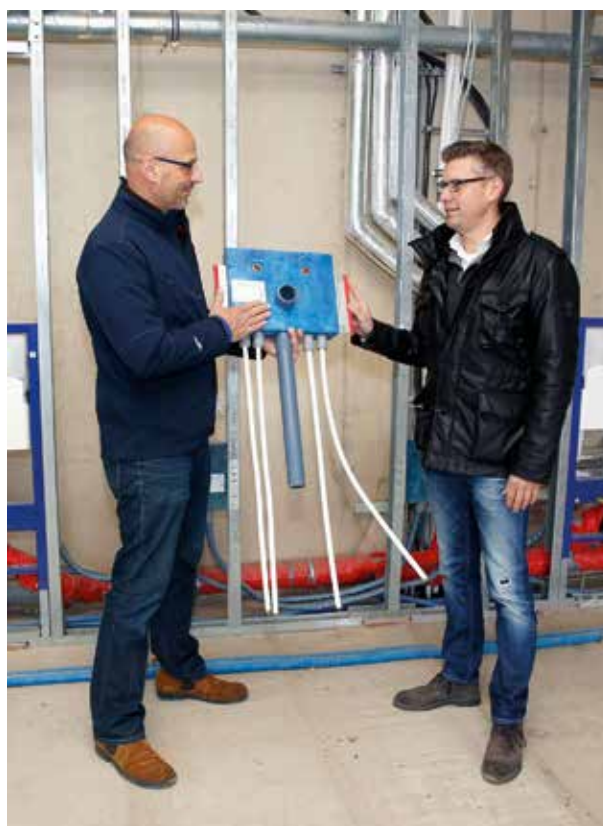
Mit Smart ISI kam in den Nutzeinheiten eine anschlussfertige und werkseitig bereits komplett wärmeisolierte und schalldämmte Installationslösung für den Trockenbau zum Einsatz
