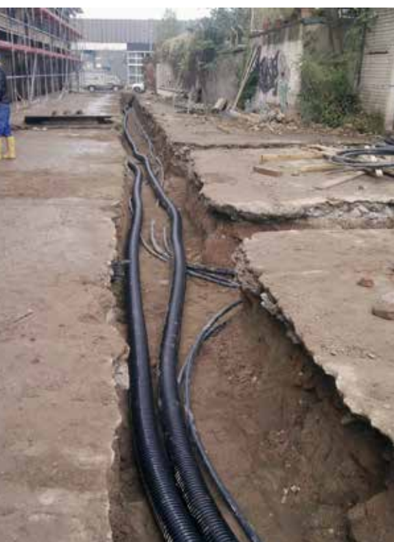
Bild links: Die Anbindung der Heizzentrale erfolgte angesichts massiver Fundamente mit bis zu zwei Meter starken Betonwänden in engen Schächten über das besonders flexible Rohrsystem Ecoflex von Uponor
