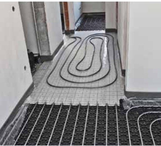
Bilder 5 und 6: Heizkreislauf auf dem Vlies
