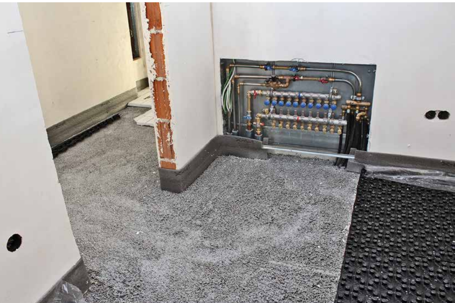
Bild 1: Heizkreisverteiler
