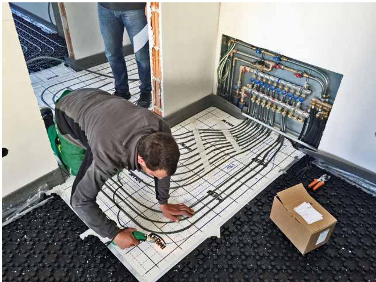
Bild 2: Einschneiden der Rohrkanäle
