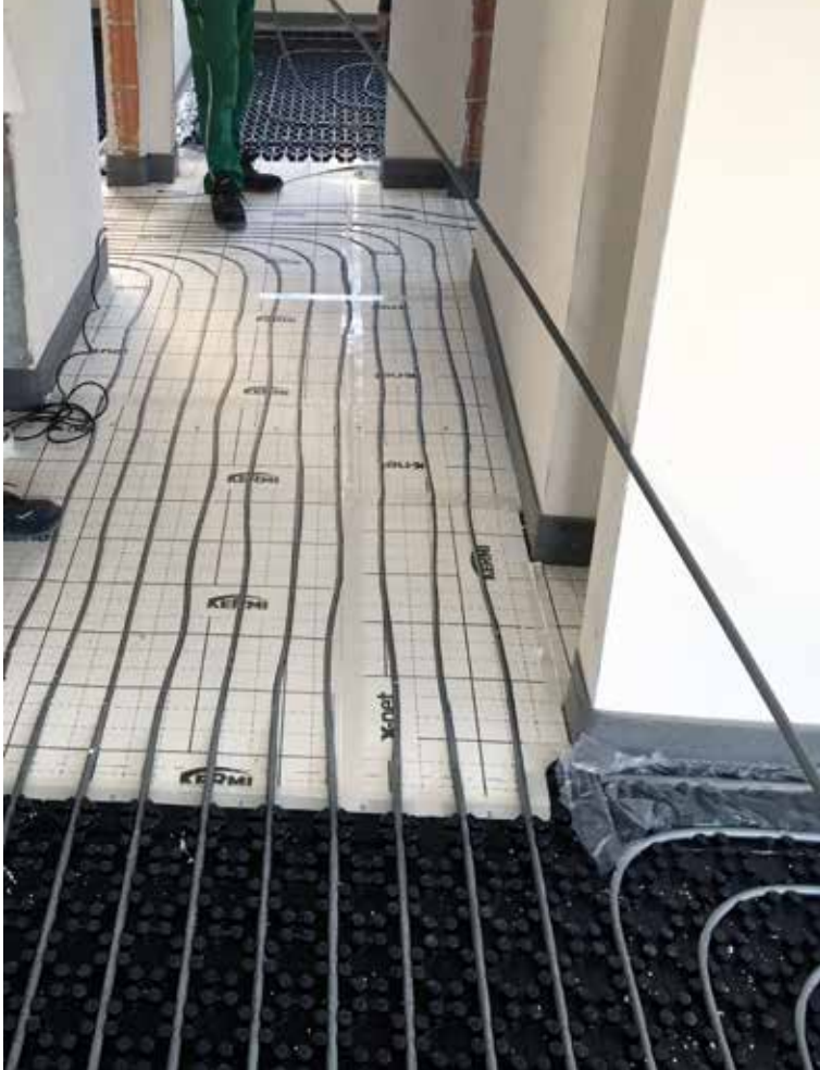
Bild 3: Übergang Noppenplatte zu Dämmplatte
