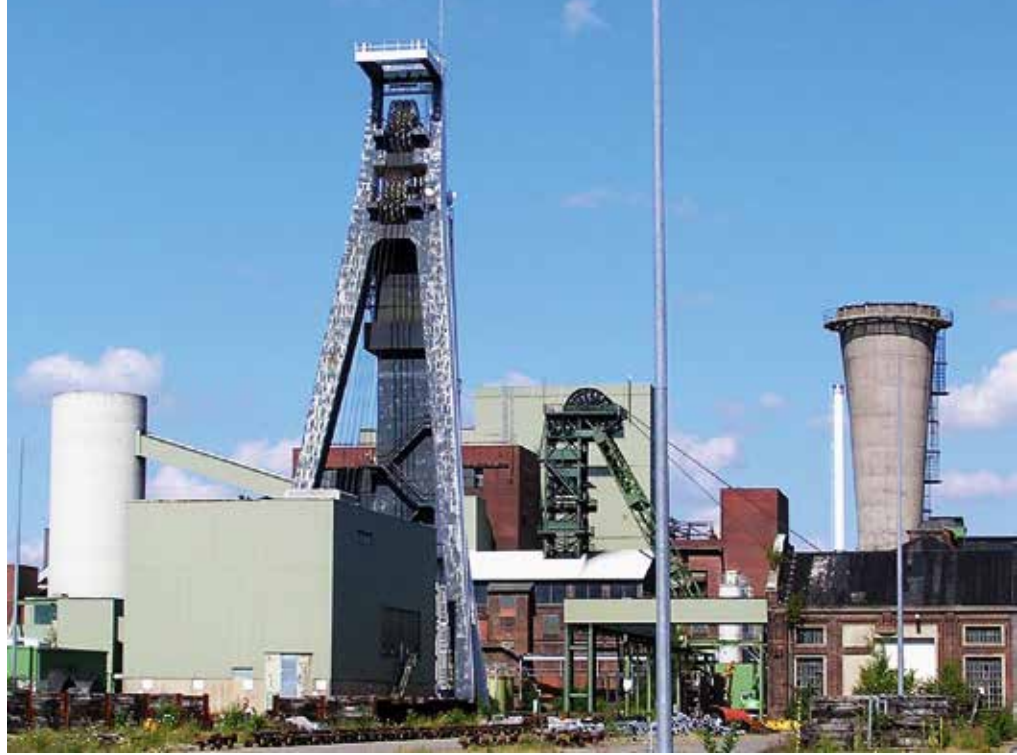
Stillgelegte Zeche Fürst Leopold, Dorsten. Schuld an Rost und Stagnation?
