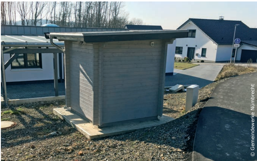
Unscheinbar wirkt das kleine Betriebshäuschen, das die Umwälzpumpen, die Wärmetauscher zur Einbindung der Solarthermie und die Regelungstechnik beinhaltet. Die Wärmepumpen stehen in den einzelnen Gebäuden
