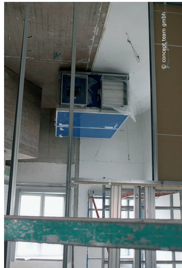
Bild rechts: Die zentralen Lüftungsgeräte bauten die Fachhandwerker in dezentraler Weise ein. Eine begehbare Zwischendecke beherbergt jetzt die beiden Duplex-Geräte
