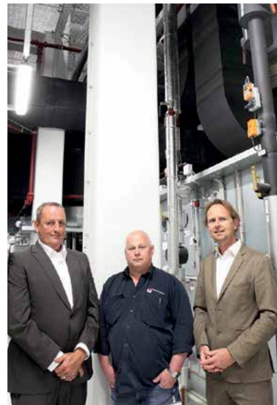
Armacell Mitarbeiter Remco Hiemstra mit Hans de Klein von Riweltie BV und Sander Bottenheft, Projektleiter bei Unica Installatietechniek
