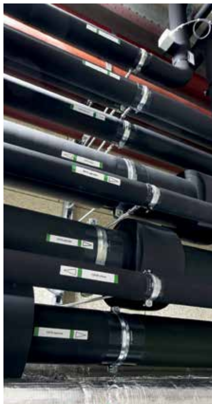
Armafex Rohrträger entkoppeln Rohrleitung und Befestigung thermisch voneinander und bilden so zusammen mit der anschließenden Armaflex Dämmung ein langfristig sicheres Dämmsystem bei Kälteanlagen (Foto: Armacell)
