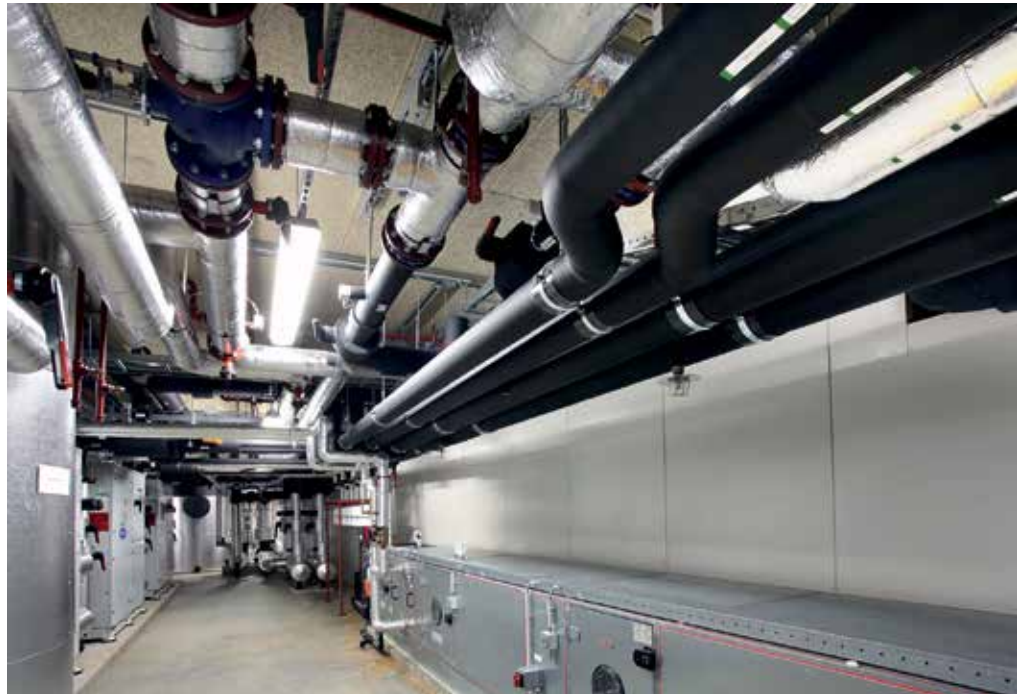
Zur Isolierung der Leitungen und weiterer Anlagenteile in den Technikzentralen setzen die Mitarbeiter des Isolierbetriebs Riweltie BV AF/Armaflex Schläuche und Platten in Dämmschichtdicken von 16 und 19 mm ein (Foto: Armacell)
