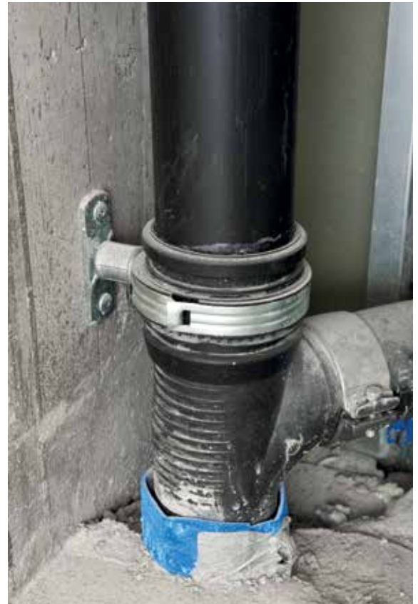
Systemrohrschellen sorgen für eine wirksame Schallentkopplung vom Baukörper
