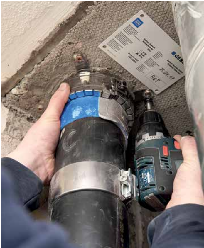
Das Rohrschott 90Plus DIN sorgt bei den Decken- und Wanddurchbrüchen dafür, dass sich Feuer und auch Rauch im Brandfall nicht über das Entwässerungssystem in nebenliegende Räume ausbreiten oder die nächste Etage ausbreiten können.
