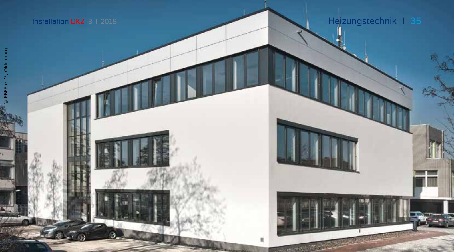
Komplett energetisch modernisiert: Gebäude II des sechsteiligen Schulkomplexes des BFE in Oldenburg.
