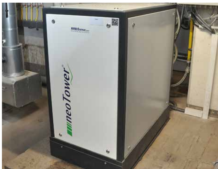
Das modulierende neoTower-BHKW Premium M 20.0 von RMB/Energie ist auf Dauerbetrieb ausgelegt.
