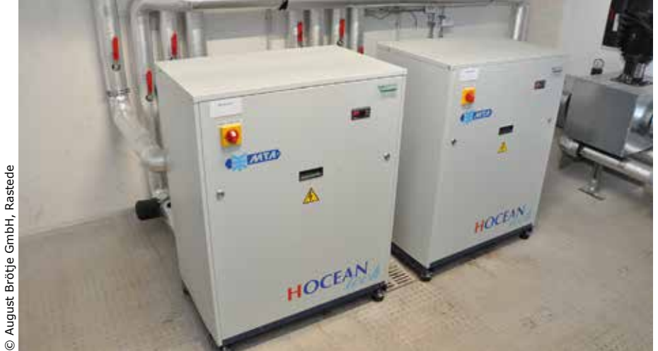
Die wassergekühlten Wärmepumpen des Herstellers MTA: Sie ermöglichen - zusätzlich zur Heizfunktion mit max. 48 kW - eine passive und aktive Kühlung der Lehrräume mit bis zu 57,5 kW Kühlleistung.
