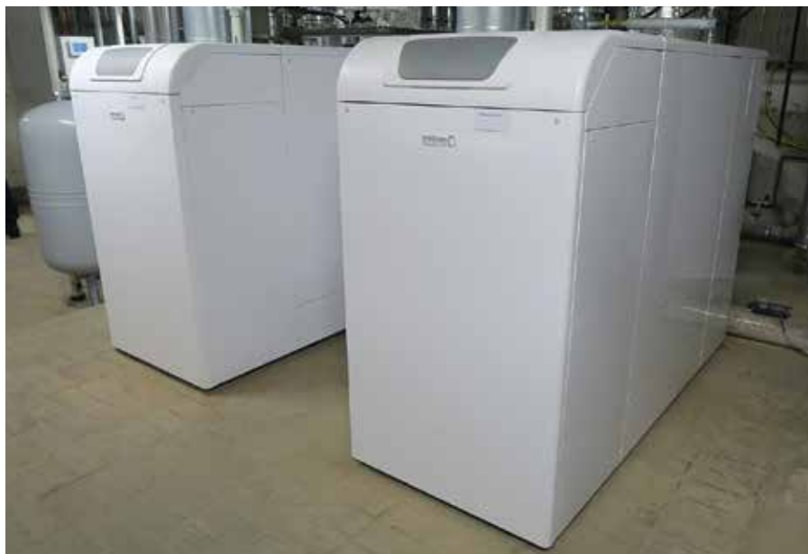
Wichtigste Säule der trivalenten Wärmeerzeugung sind die zwei EuroCondens 400 aus dem Hause Brötje. Kompakte Bauweise und geräuscharmer Betrieb inklusive.
