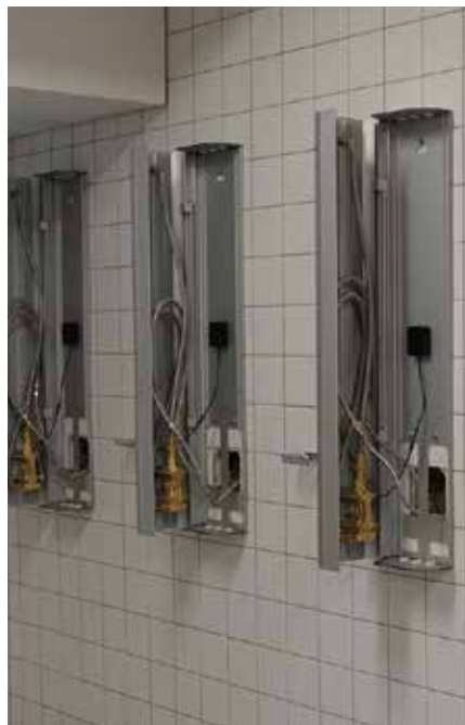
Mit CVD-Touch-Elektronik, Thermostat und Verbrühschutz bei 38°C sowie einer Klappmechanik für die einfache Revision eignet sich das Duschpaneel Linus DP-C-T speziell für die Objektsanierung.
