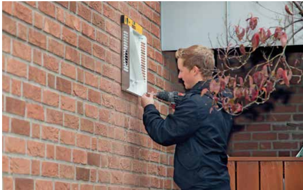
Die Halterung für die Außenwandhaube des Zehnder ComfoSpot 50 ist mit wenigen Handgriffen angeschraubt. Der im Gerät integrierte Enthalpietauscher macht eine Kondensatabscheidung überflüssig, es kann zu keiner Feuchtigkeitsbildung kommen, welche an der Fassade hinabläufe.
