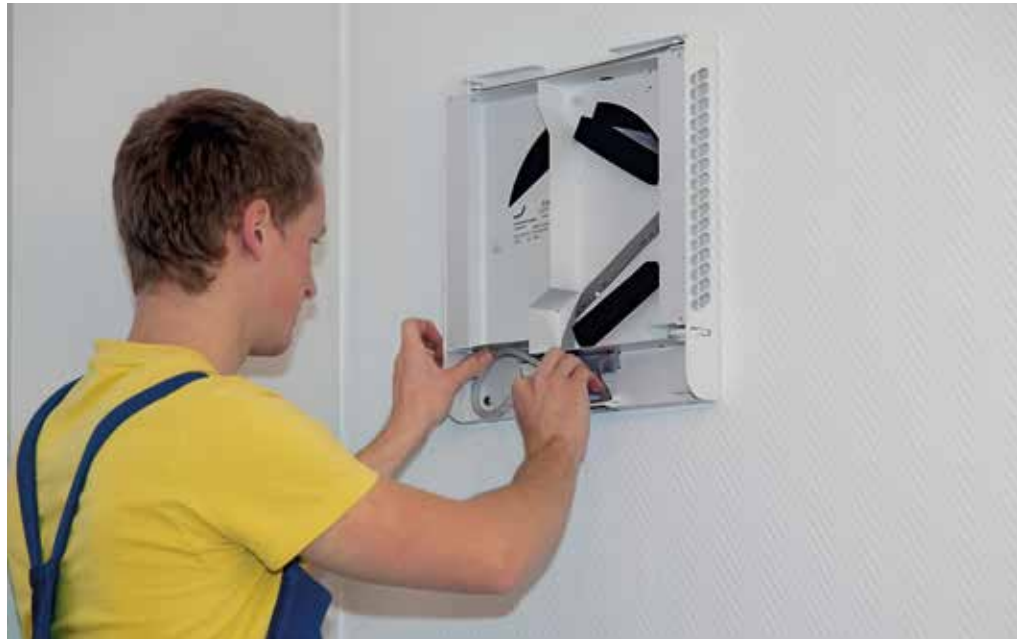
Nachdem das Gerät in der Wand verschwunden ist, schließt der Monteur den Strom an und befestigt die Halterung der Innenverblendung. Das flache Element beinhaltet auch das Steuerpanel und die Filterwechselanzeige.
