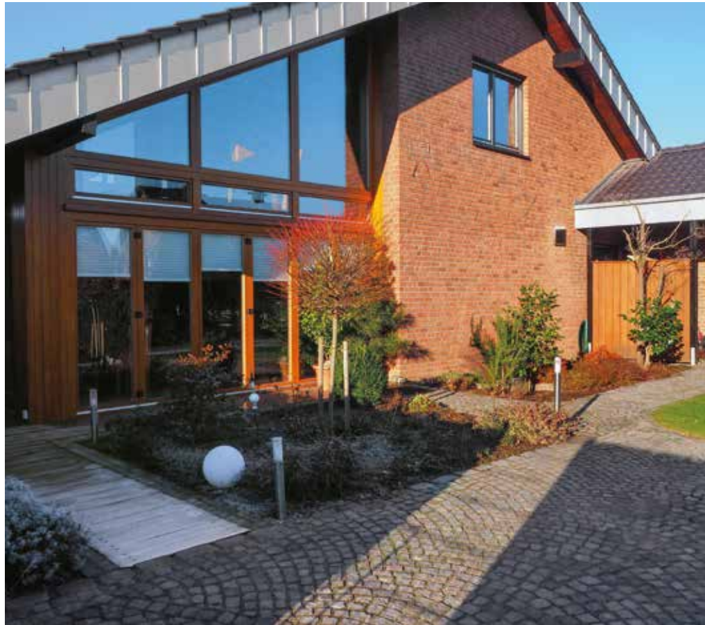
Das Schlafzimmer im Erdgeschoss rechts wurde ursprünglich durch die Terrassentür mit frischer Außenluft versorgt. Seit der Umgestaltung der Veranda zum Wintergarten war dies nicht mehr möglich. Nach einem minimalen Eingriff in den Baukörper sorgt nun ein unauffälliges dezentrales Komfort-Lüftungsgerät für optimales Raumklima.
