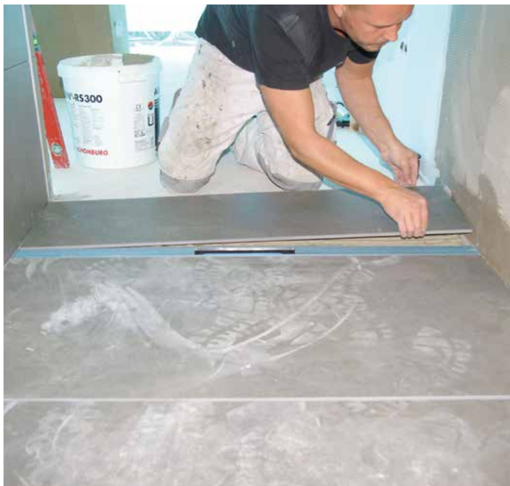
Abb. 2: Die Abdichtung des Bodenablaufs im Verbund ist seit Jahren gängige und bewährte Praxis. Dem trägt jetzt auch die neue DIN 18534 Rechnung.
