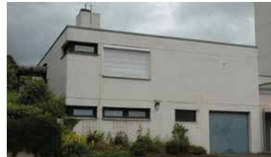
Das ehemalige Wohnhaus des Hausmeisters der Radko-Stöckl-Schule war ener- getisch gesehen eine Katastrophe. Entstan- den ist ein Passivhaus, das am Objekt zeigt, wie die Energiewende gestaltet werden kann.
