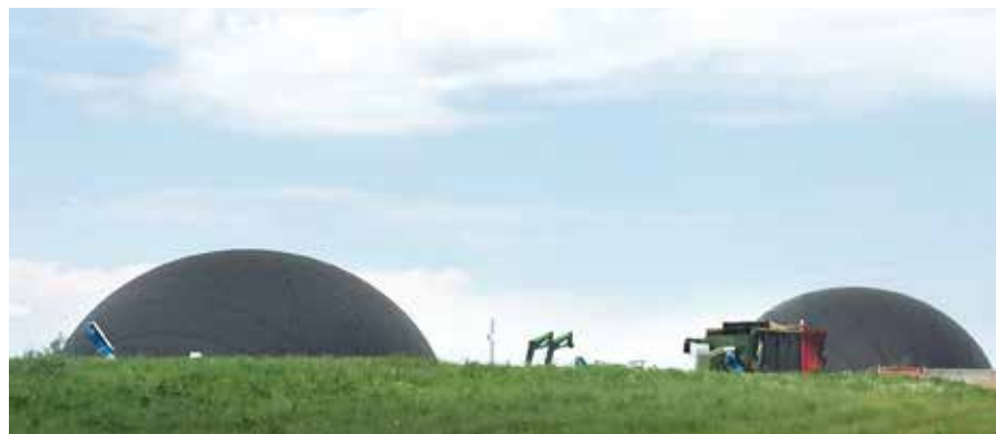
Mit der Kombination aus Biogasanlage und Hackschnitzelanlage sind Versorgungssicherheit und Spitzenlastdeckung für das Nahwärmenetz gewährleistet.
