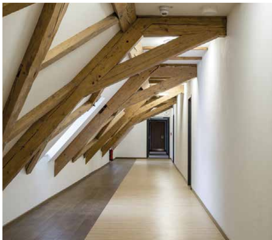
Im Dachgeschoss der Realschule wurde zunächst eine Schicht aus klassischen NORIT-TE 20-Elementen auf dem über der Holzbalkendecke ausgebrachten Ausgleichsbeton gelegt. Darüber folgten dann NORIT-TE 30 Therm GF-Platten aus Gipsfaser.
