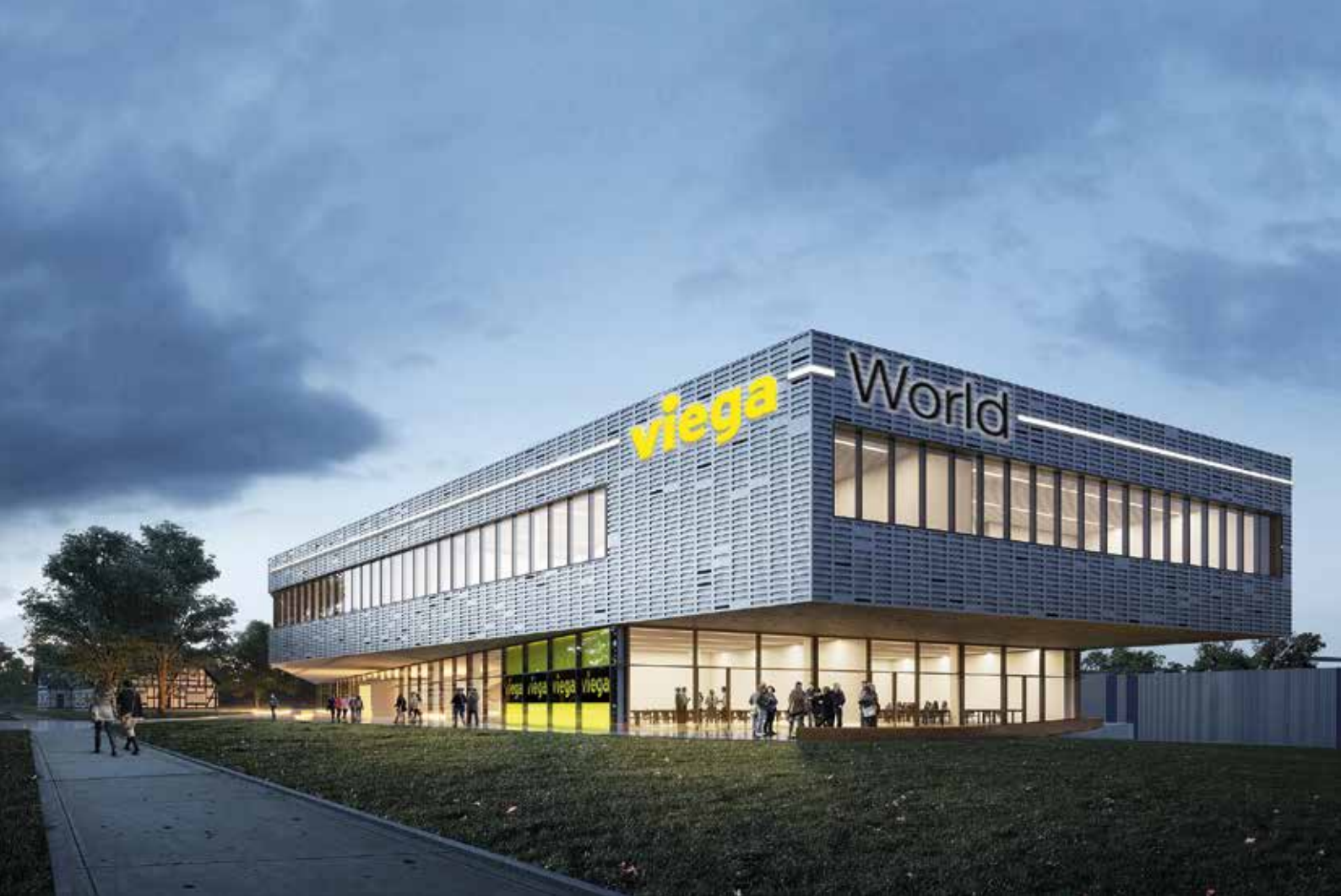
Die „Viega World“ am Standort Attendorn-Ennest wird ein Referenzprojekt des digitalen Bauens. Das Schulungszentrum ist integral geplant und wird mit dem Planungswerkzeug BIM (Building Information Modeling) konsequent entlang eines digitalen Modells realisiert. (Abbildung: Viega)
