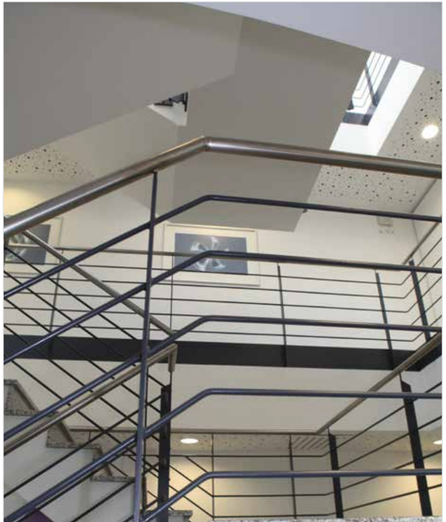
Werden bestehende Gebäude aufgestockt, ist mitunter der geforderte zweite Rettungsweg neben dem bestehenden Treppenhaus schwierig herzustellen. Sicherheitstreppe räume bieten hier den Ausweg.
