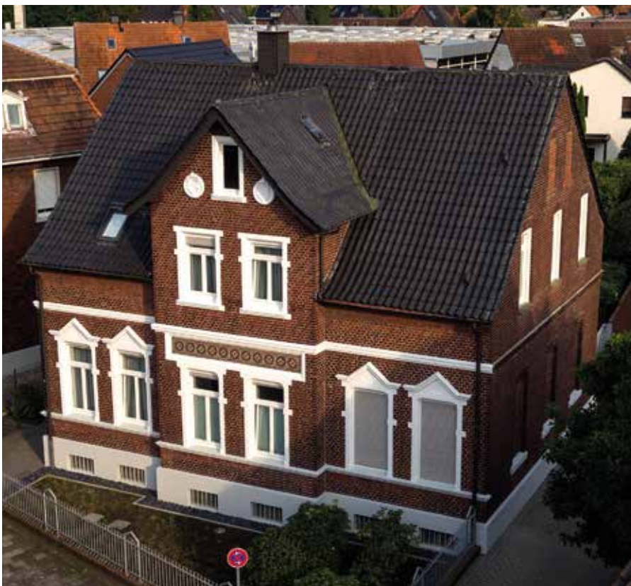
Frisch in den Hotelkomplex des Lindenhofs integriert: In dem kernsanierten historischen Gebäude wurden sechs Zimmer mit dem stromlosen Dusch-WC TECEone ausgestattet.
