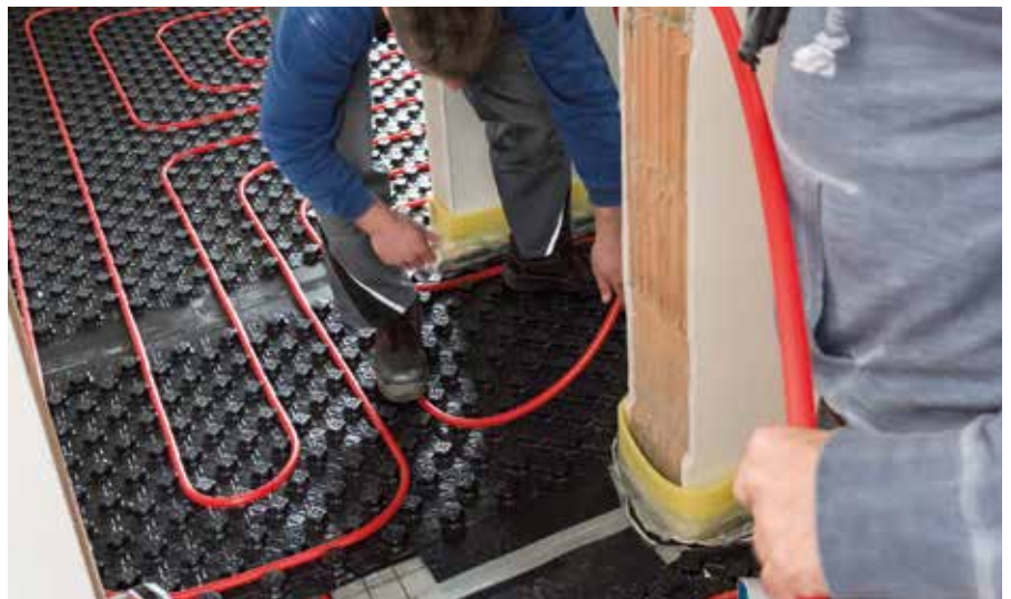
Im achten Schritt wurde der separat regelbare Heizkreis im Transferraum installiert und ebenfalls am Heizkreisverteiler angebunden.
