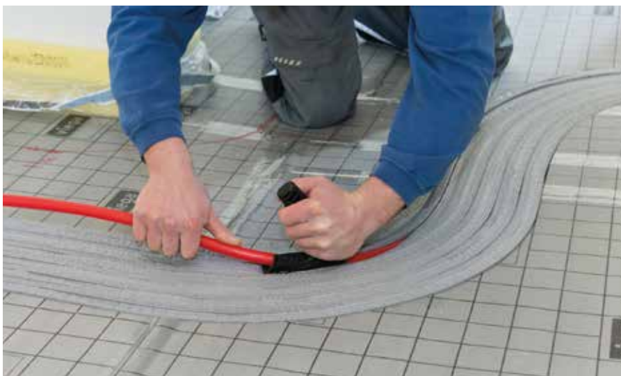
Als Nächstes wurden mit einer Rohrzughilfe die bereits am Heizkreisverteiler angeschlossenen Rohrleitungen in die geschlitzten Dämmschläuche eingeführt.
