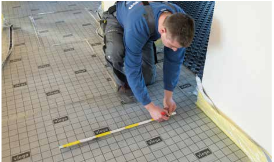
Im zweiten Schritt wurden die Zuleitungswege – hier im Obergeschoss – mit Anzahl der Zuleitungen vom Heizkreisverteilerschrank in die benachbarten Räume aufgezeichnet.
