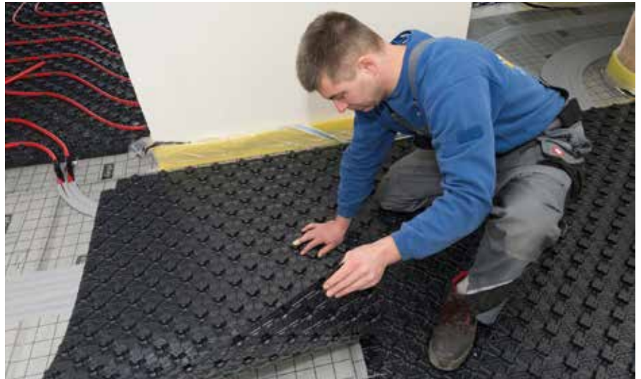
Siebtens: Markus Schmid verlegte die Noppenplatte „Fonterra Smart“ auf der Tackerplatte im Transferraum.
