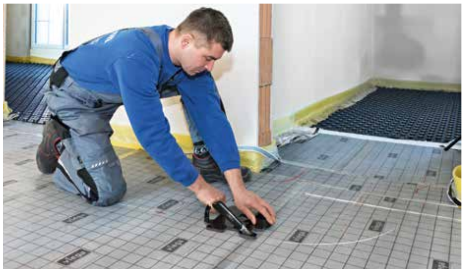
Als Drittes schnitt Markus Schmid die Tackerplatte in der Breite der Leitungswege aus.
