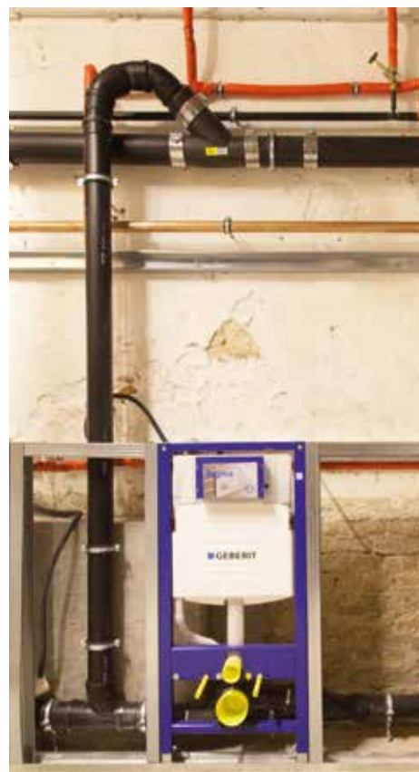
Halbhohe Vorwandinstallation mit Geberit Duofix Montageelementen.
