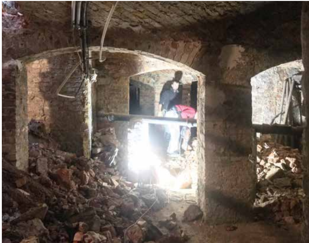
Versorgungsrohre führen mitten durch den alten Gewölbekeller. Trotzdem: André Kanya erkennt das Potenzial der Räume in Berlin-Kreuzberg und plant einen Artspace mit Bar.
