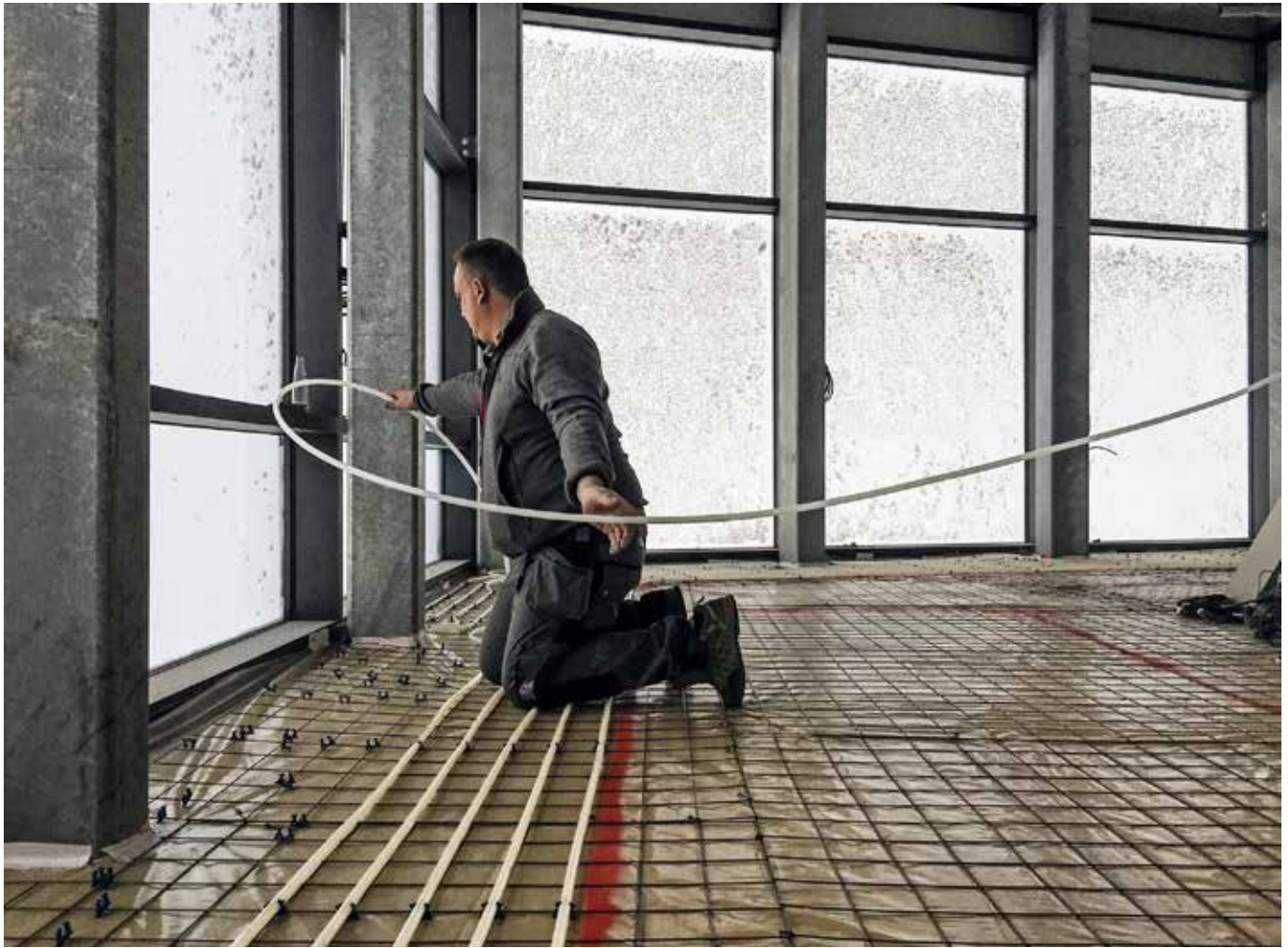
Die beschichteten Trägerelemente und die robusten Rohrhalter fixieren die Systemrohre zuverlässig in der Heizebene und ermöglichen eine sehr gute Estrichumschließung.
