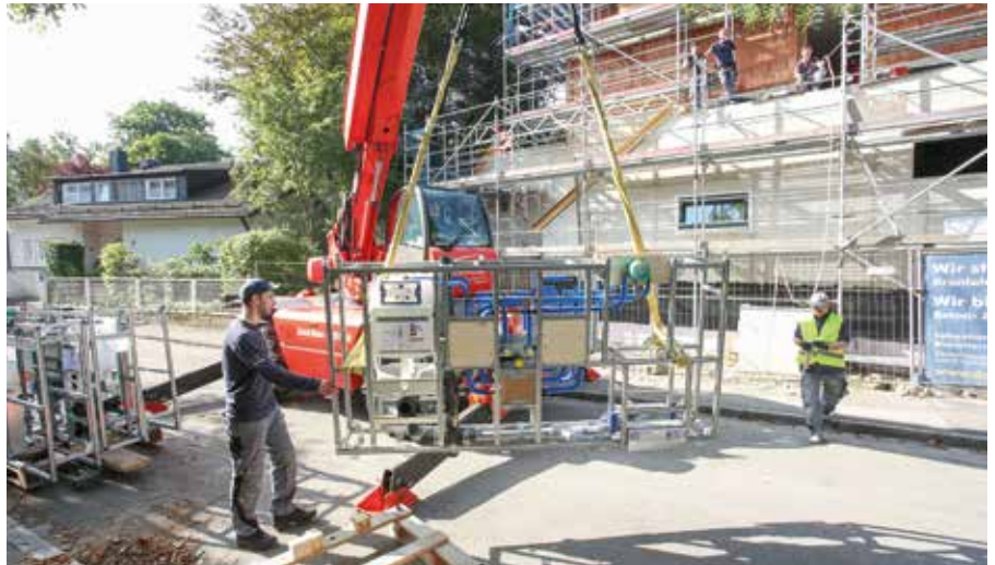
Per Kran werden die Einzelteile in das Gebäude gehoben.
