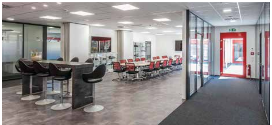
Eingangsbereich mit Kühldecke und Flächenheizung. (Foto: Fritz Schöttner)
