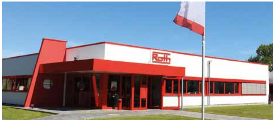
Selbst in der heißen Sommerperiode 2018 mit Außentemperaturen von weit über 30 Grad Celsius hatten die Büronutzer bei Roth Plastic Technology durchgängig angenehme Raumtemperaturen unter 26 Grad Celsius.
