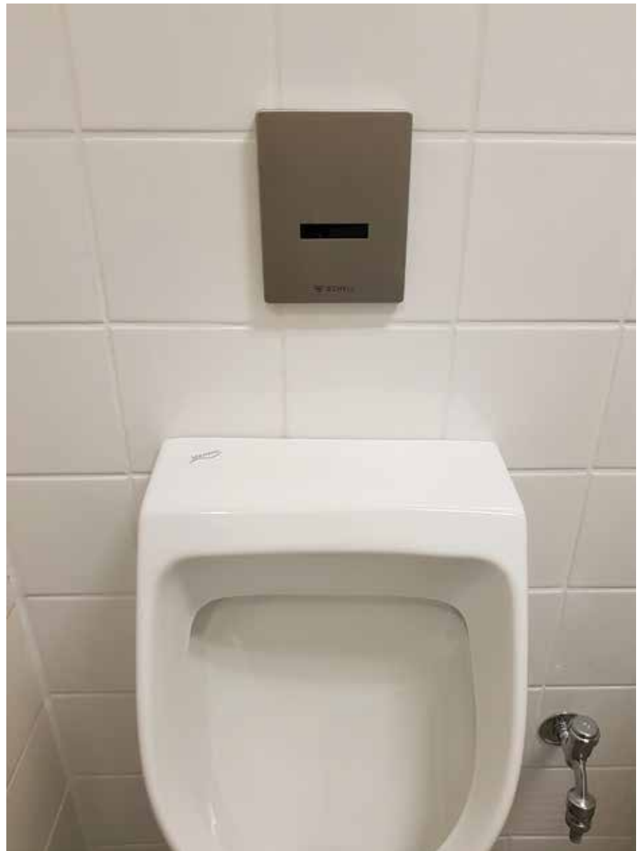
! Funktionell und modern: eine der Urinalanlagen mit berührungslosen Steuerungen „Edition E“.
