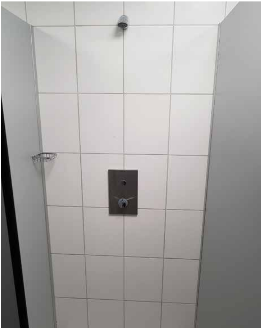
Das Wassermanagement-System bietet auch für die Duscharmaturen „Linus“ mit CVD-Touch-Elektronik praxisgerechte Flexibilität durch zentrale Parametrisierung und automatisierte Stagnationsspülungen.
