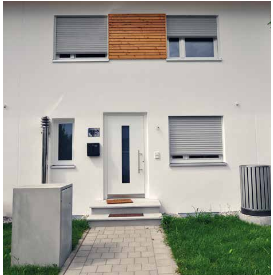
▮ Sieben moderne Reihenhäuser werden von Remko-Splitwärmepumpen versorgt. Das Außenmodul gibt sich zunächst nicht als technisches Bauteil zu erkennen.
