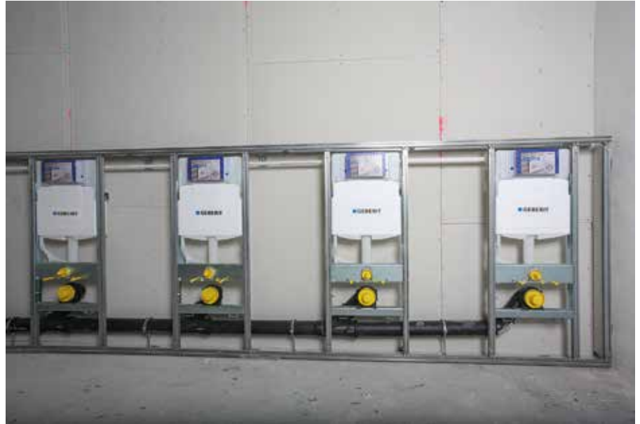
■ Klassisch in Reihe sind die Kinder-WCs angebracht, die ebenfalls mit GIS und Spülkästen Geberit Sigma realisiert sind.
