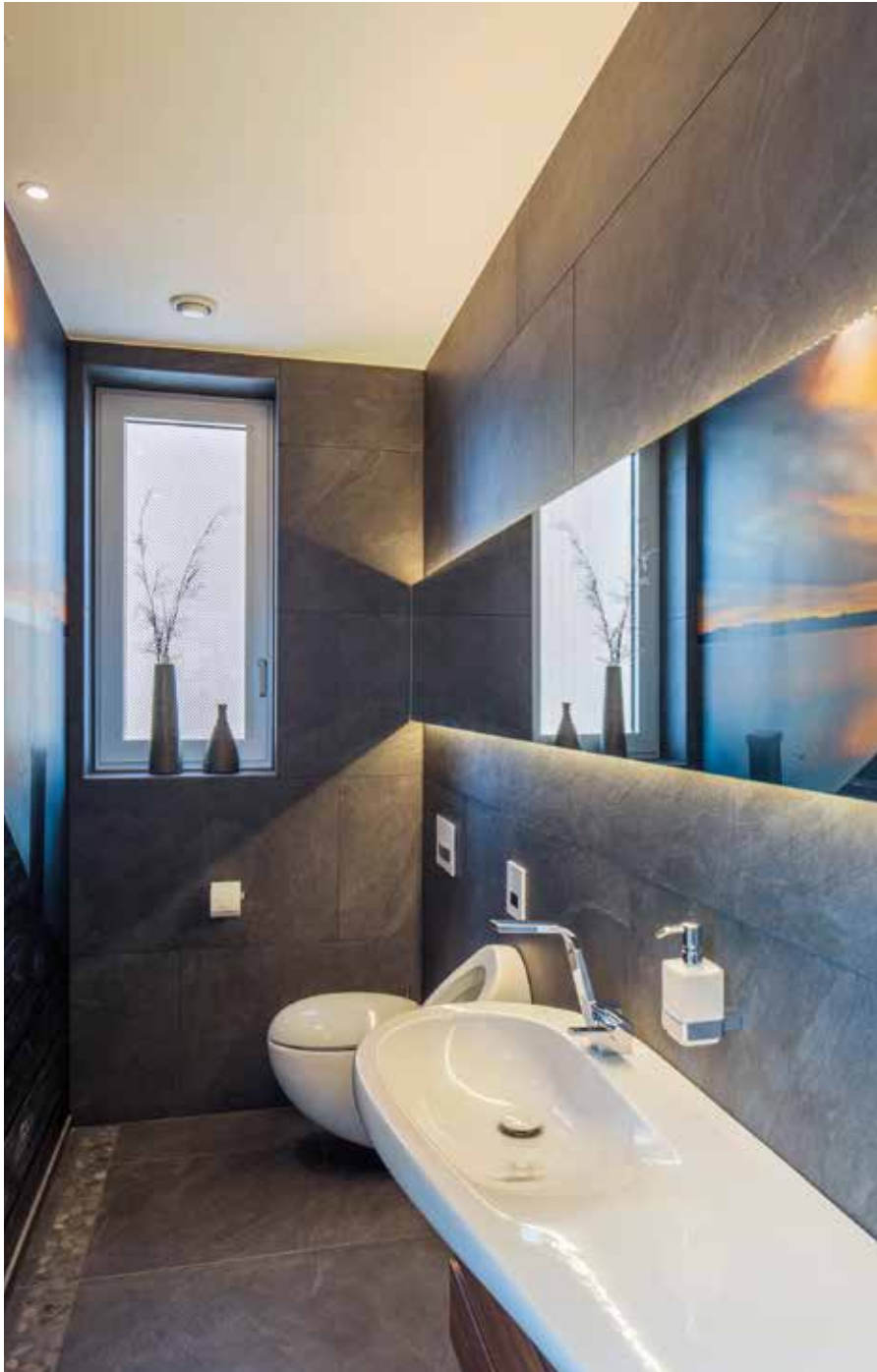
Die Gipskartondecke von Zehnder (hier in der glatten Ausführung) ist durch ihre weiße Farbe optisch unauffällig und fügt sich dezent in die Räume der Jäger Haustechnik, wie hier in die Toilette, ein. Der Werkstoff Gips ist ein 100% mineralisches Naturprodukt.
