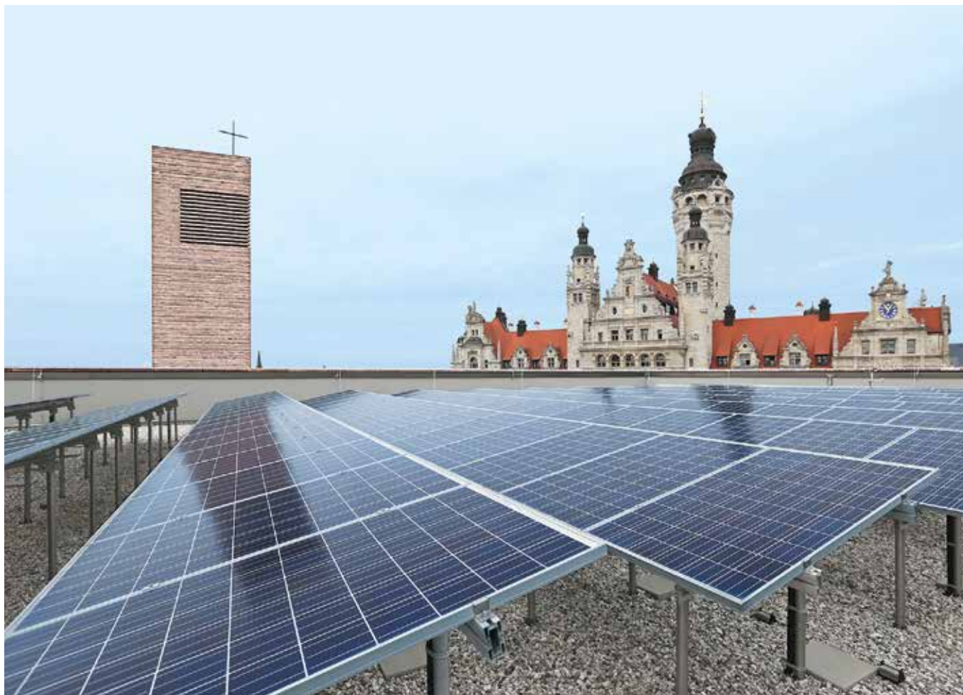
! Auf dem Dach der Probsteikirche produziert eine 54-Kilowattpeak-PV-Anlage grünen Strom.
