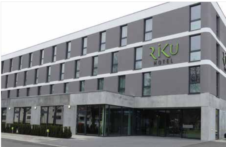
Das neue RiKu Hotel im oberschwäbischen Pfullendorf öffnete Ende Dezember 2018 seine Türen. Auf einer Grundfläche von rund 3.600 Quadratmetern bietet das Hotel Platz für 60 komfortable Doppelzimmer. Foto: Geberit
