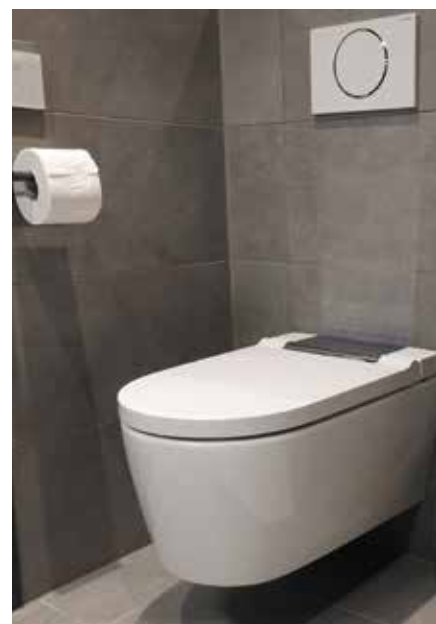
In zehn Hotelbädern ist das neue Dusch-WC Geberit AquaClean Sela eingebaut. Dank seinem puristisch-eleganten Design und der verdeckten Befestigung fällt es nicht als Dusch-WC auf. Die intelligente Technik ist unsichtbar in die Keramik integriert. Ebenso wie das AquaClean Mera wird auch dieses Modell per Wandbedienpanel bedient.
