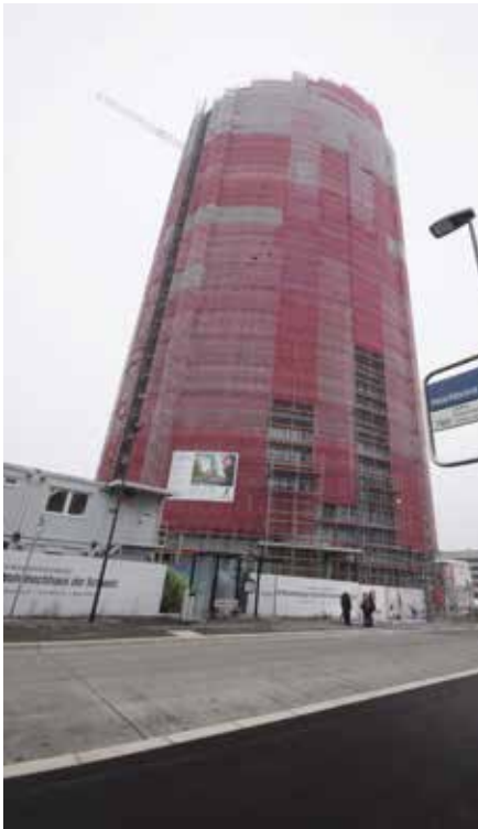
I In der Bauphase im November 2018 zeigte er sich noch bedeckt: Der Dübendorfer Jabee-Tower ist dabei, ganz groß rauszukommen.
