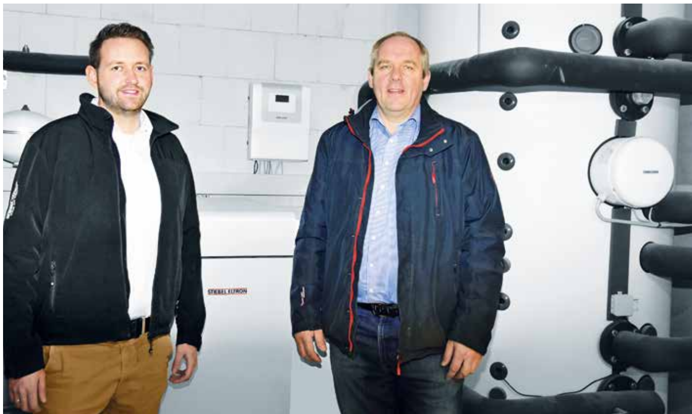
Investor Manfred Stahlmann (rechts) und Stiebel-Eltron-Produktmanager Tobias Pach im Heizraum des Gebäudes vor der Wärmepumpe WPF 27.
