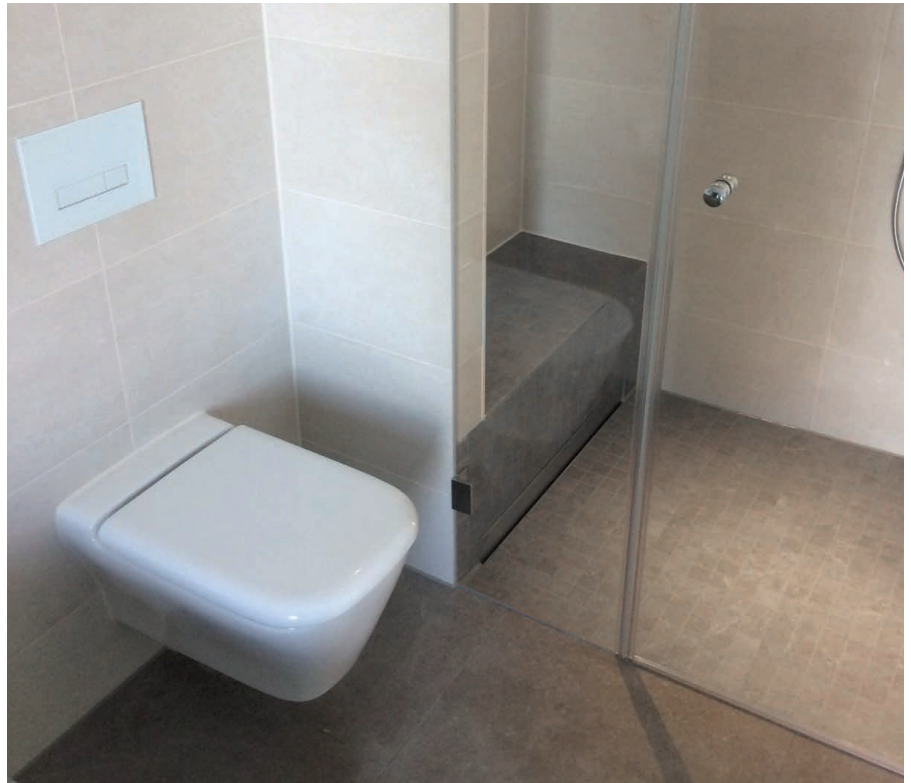
! Auch von MEPA: Das „VariVIT“-Vorwandsystem mit UP-Spülkasten „Sanicontrol A31“ und Betätigungsplatte „MEPAorbit“.
