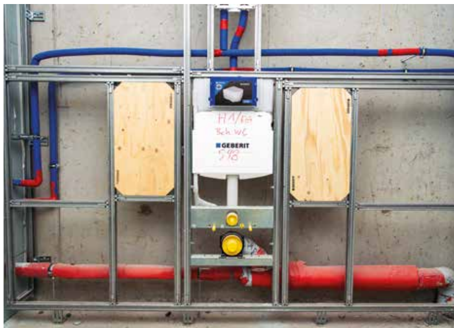
Unter anderem entstanden auch barrierefreie Sanitärräume mit Montageplatten für Stützgriffe an den WCs.
