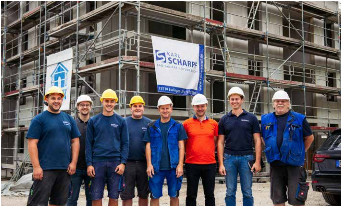
Ein achtköpfiges Team des Fachbetriebs Karl Scharpf GmbH & Co. KG aus Esslingen schloss im September 2019 die Installationsarbeiten ab.
