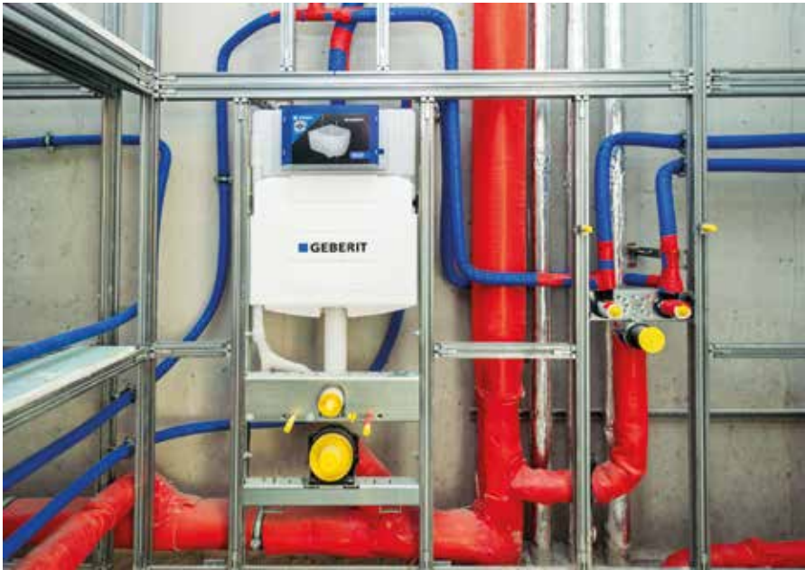
Die Installateure montierten alle Sanitärinstallationen mit dem Geberit Installationssystem GIS vor Ort auf der Baustelle, denn die meisten Grundrisse der rund 120 Sanitärräume unterscheiden sich voneinander
