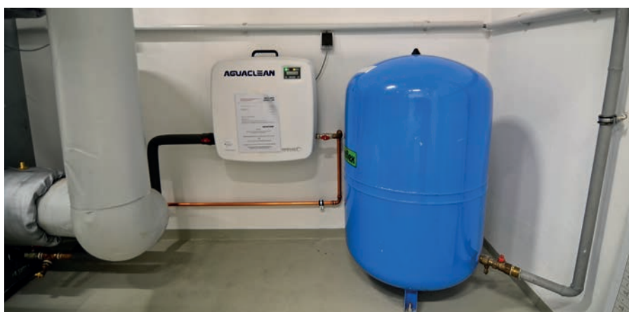
Das AquaClean-Modul reinigt das Heizungswasser und filtert beispielsweise auch kleinste Magnetitpartikel heraus, die Leitungen und Pumpen schädigen könnten.
