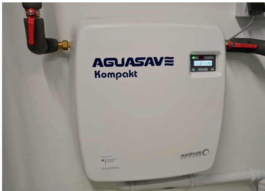
Über dem Wasseraufbereitungsmodul AquaSave von Brötje befinden sich drei Boxen, die die netzgebundene Datenfernübertragung für das Heizungsanlagen-Monitoring beherbergen.
