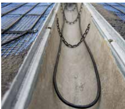
In den Absaufrinnen werden zusätzlich AEG Heizkabel verlegt und mittels PE-Stegen fixiert.
