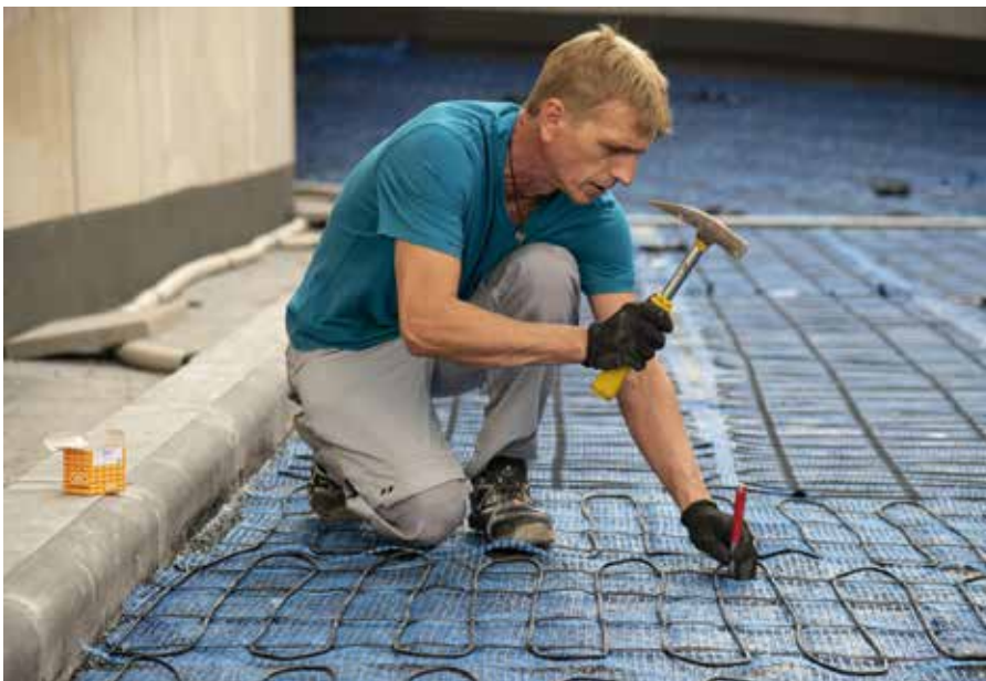
Bei der Befestigung der Heizmatten auf dem Untergrund darf der Heizleiter nicht beschädigt werden – nur das Trägerband der Heizmatte wird mit einem Dübel, Nagel oder Bolzenschussgerät fixiert.
