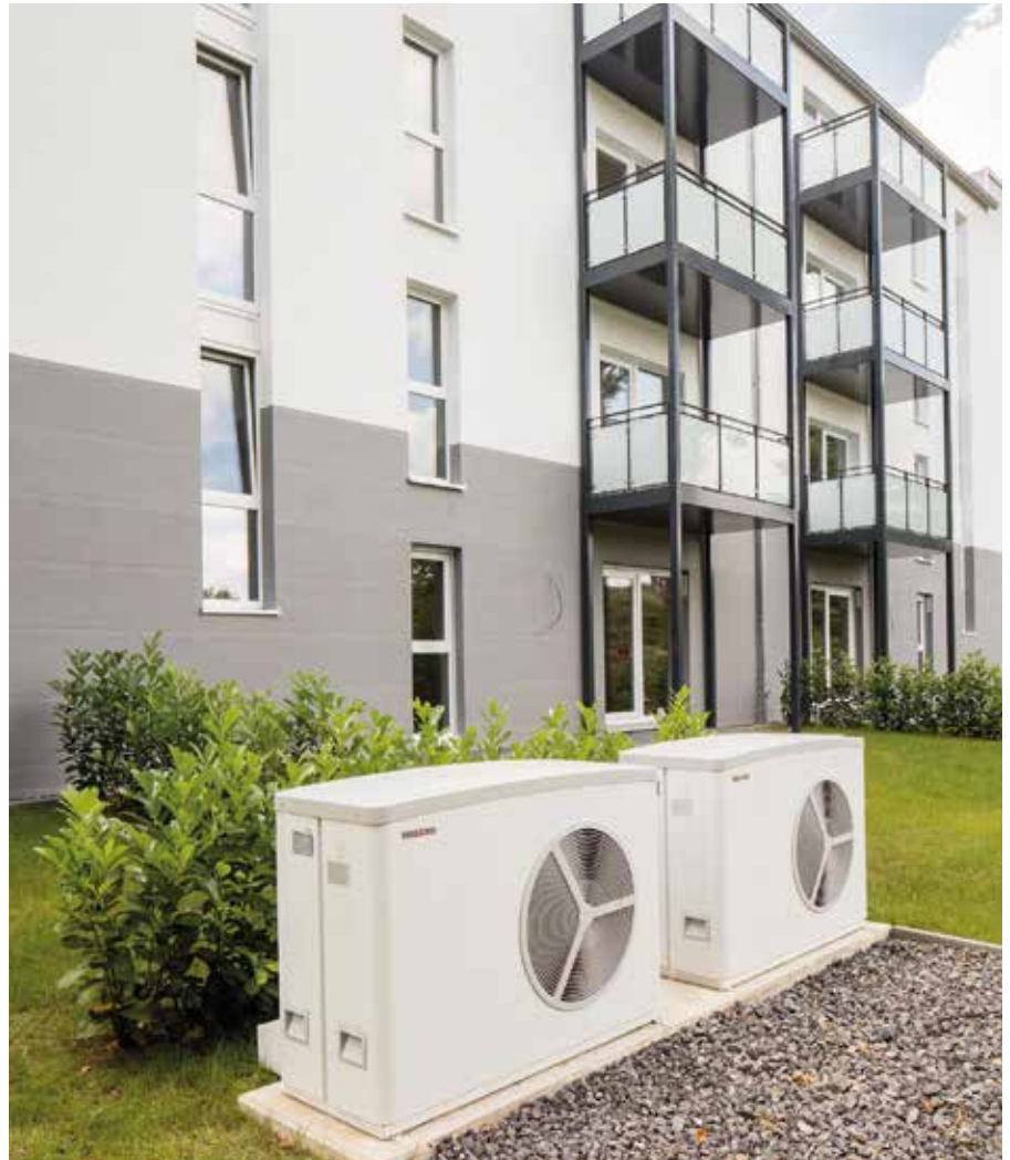
▮ Jedes Gebäude mit neun Wohneinheiten wird von einer Kaskade aus zwei Luft-Wasser-Wärmepumpen WPL 25 A mit Wärme für Heizung und Warmwasserbereitung versorgt.
