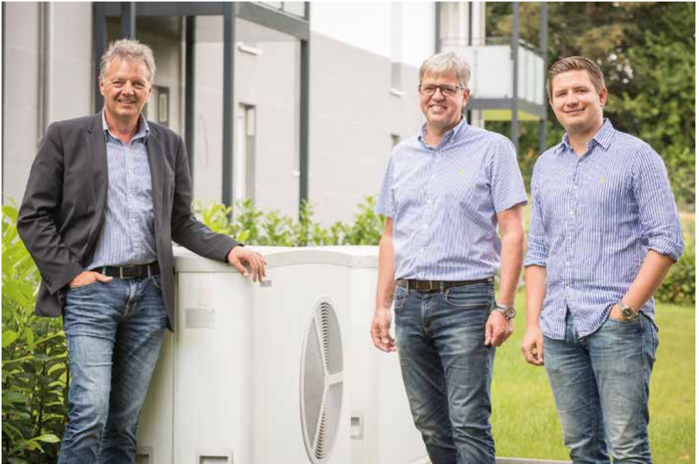
! v.l. DERICHSuKONERTZ-Niederlassungsleiter Aachen Uwe Thamm, STIEBEL ELTRON-Fachmann Guido Mevißen und Sebastian Thamm vom TGA-Büro „DSTR Planungsgesellschaft für technische Gebäudeausstattung“ an einer der drei Wärmepumpen-Kaskadenanlagen.
