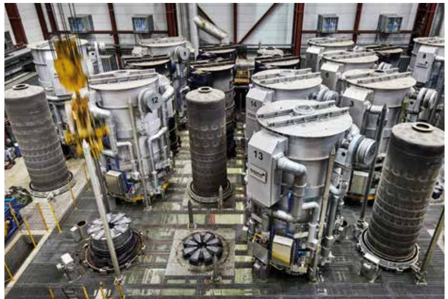
■ Blick in die neue Glühe der BILSTEIN GROUP in Hagen-Hohenlimburg, wo unter anderem kundenspezifische Stahlbleche für die Automobilindustrie gefertigt werden.
