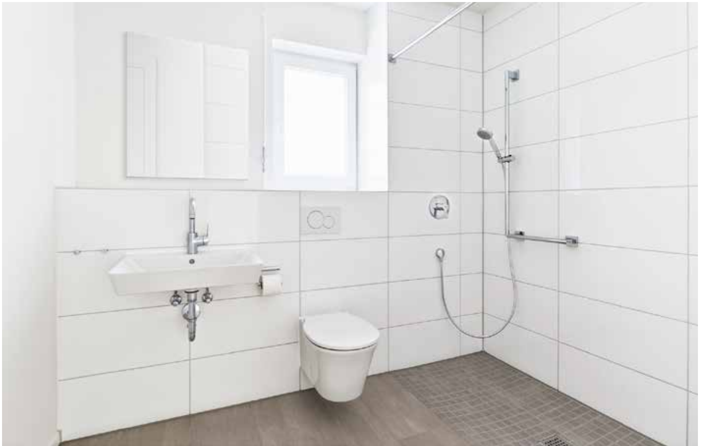
■ Ausgestattet sind alle Bäder im LBG-Bestand des Postdörfles mit CeraFlex Armaturen sowie Waschtischen in zwei Größen und WCs mit randloser Spültechnik aus der Serie Connect Air.
