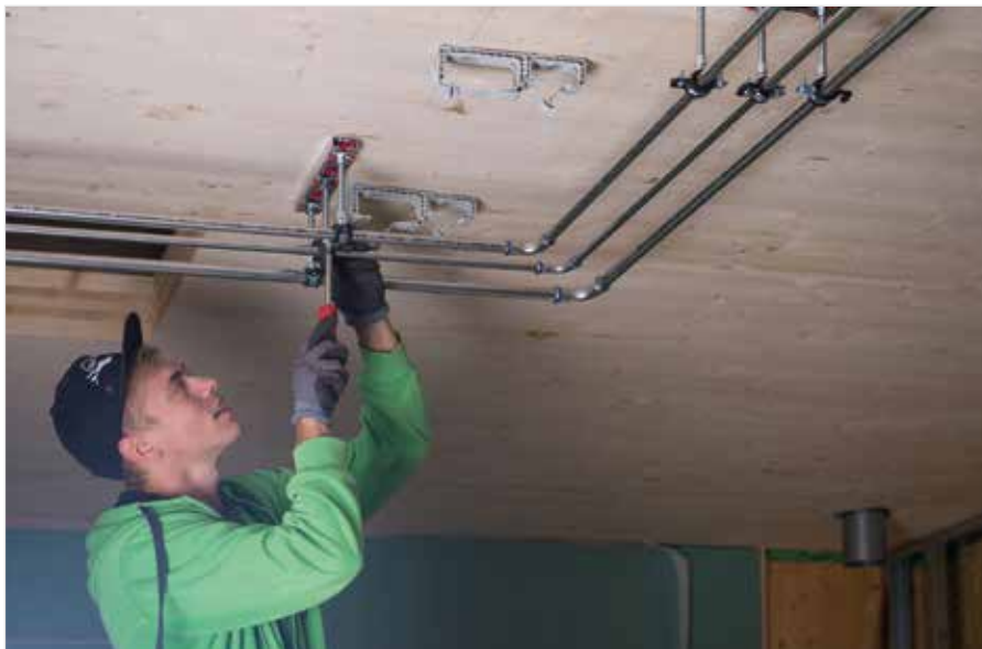
Bei der Montage der Versorgungsleitungen setzen die Monteure Geberit Mapress ein. Das Presssystem ist für den Einsatz im Holzbau ideal geeignet. Hier werden gerade die Rohrschellen verschraubt.
