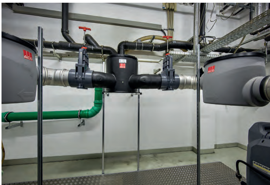
Die nach DIN EN 1825-1, DIN EN 1825-2 und DIN 4040-100 geforderte Verrohrung von Fettabscheidern aus fettsäurebeständigen Werkstoffen erfüllte ACO Haustechnik mit dem Edelstahlrohr ACO Pipe.
