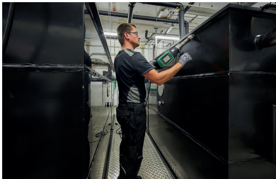
Die beengten Gegebenheiten erforderten eine spezifische Anpassung der Behältermaße, eine Anlieferung in insgesamt 16 Teilstücken sowie deren Verschweißung vor Ort.
