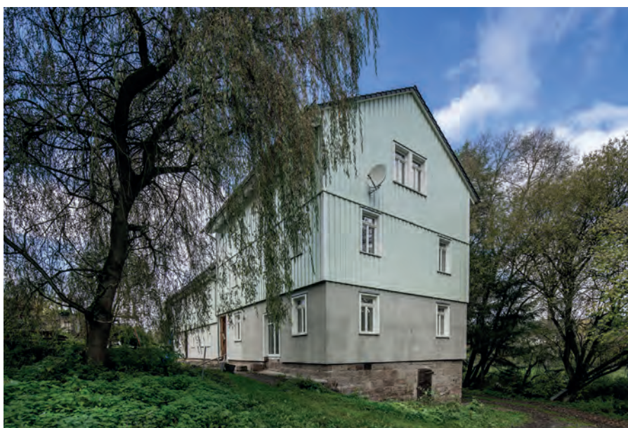
Altes Mauerwerk trifft auf moderne Energieversorgung: Das historische Mehrfamilienhaus zeigt, dass die Wärmepumpen-Technologie keinesfalls auf besonders energieeffiziente Neubauten begrenzt ist.
