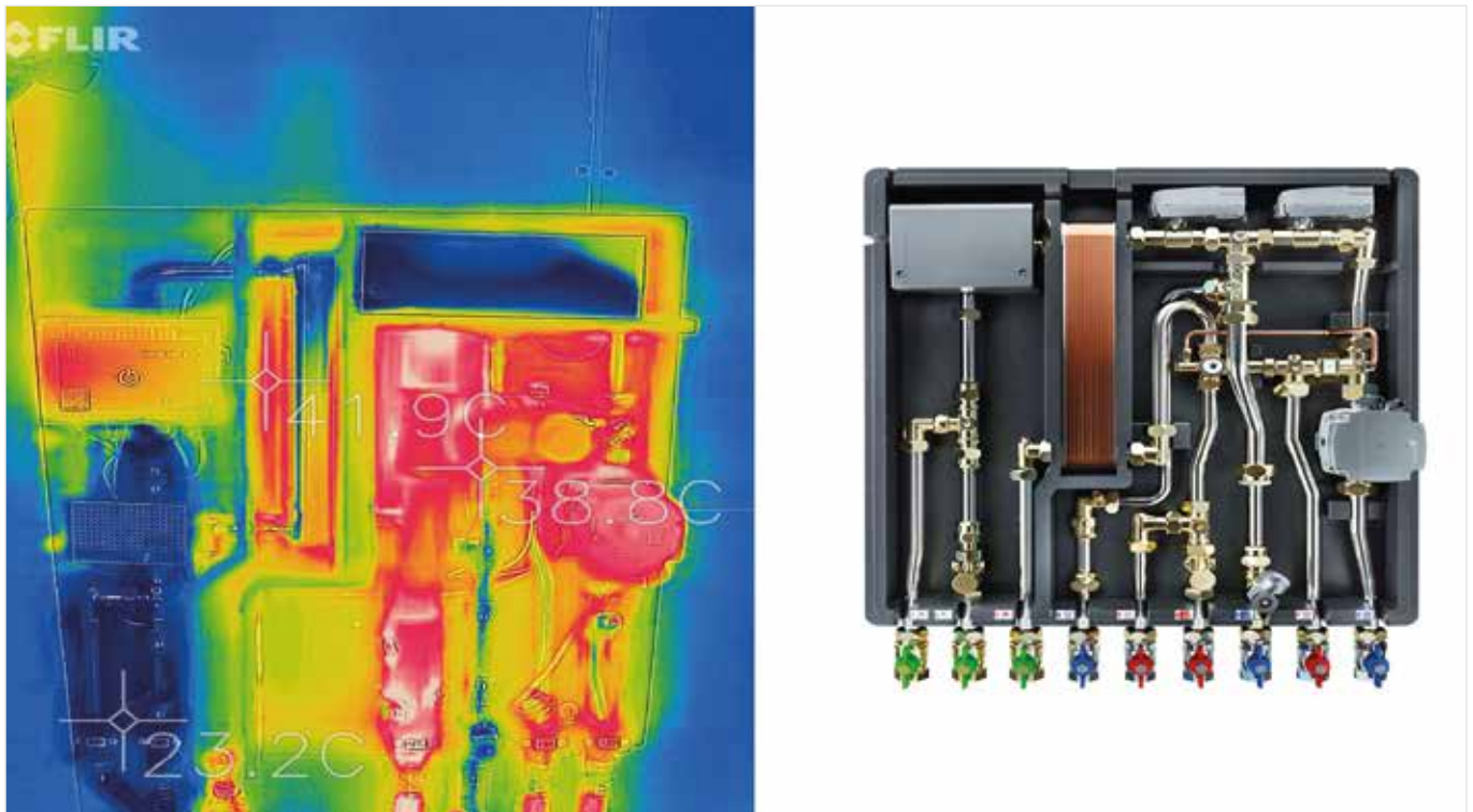
Abb. 4: Kaltes Trinkwasser bleibt kalt. Die Wohnungsstation Combi Port E von KaMo verfügt über eine thermische Trennung von warm- und kaltgehenden Leitungen. So ist kaltes Trinkwasser sicher vor Erwärmung geschützt.
