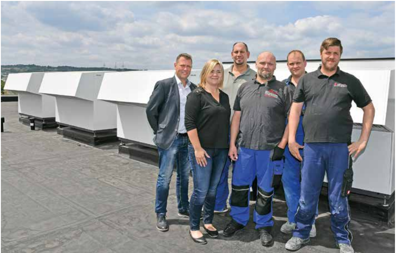
! v.l.: Andreas Zurek von Stiebel Eltron, Projektmanagerin Luise Bellmann von der GTS Group sowie Manuel Galvez-Cazorla, Inhaber des Haustechnikunternehmens „Galvez Haus- & Gebäudetechnik“, mit dessen Mitarbeitern vor den Luft-Wasser-Wärmepumpen.
