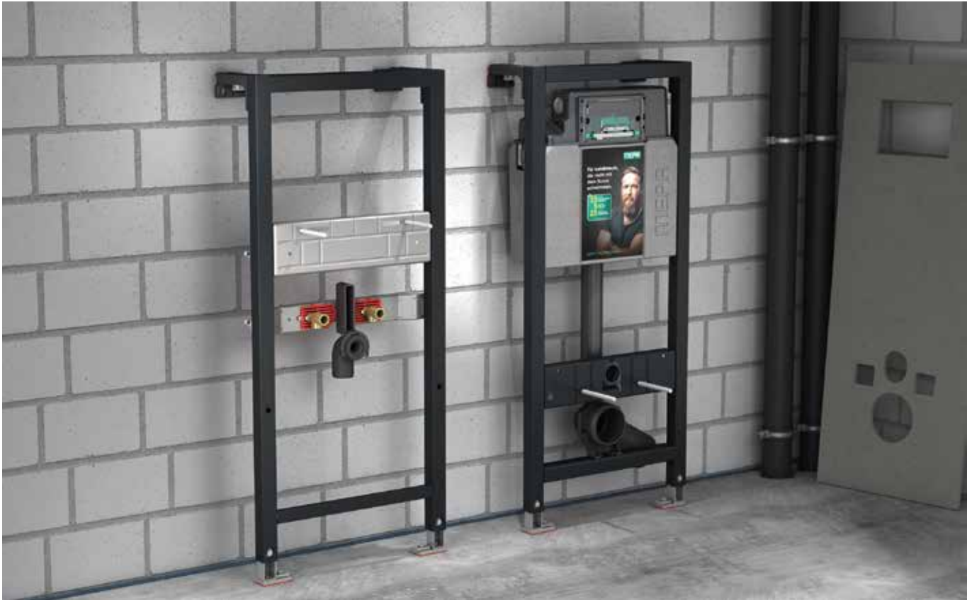
! Einzelmontage der „MEPA nextVIT“-Elemente vor einer Massivwand.
