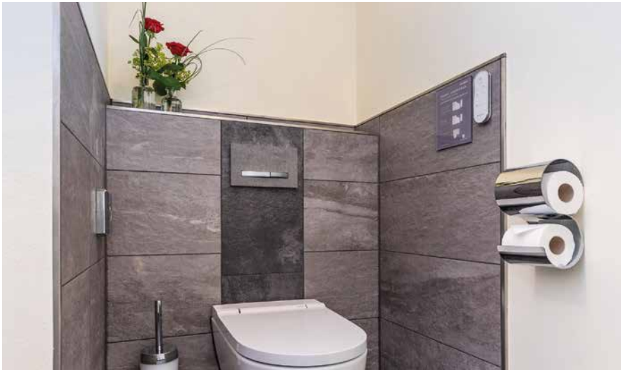
■ Mit dem Dusch-WC AquaClean Sela von Geberit überrascht der Landgasthof Hessenmühle seine Gäste. Schickes Detail: Die Spülauslösung von Geberit – Sigma50 mit Schieferplatte – fügt sich hervorragend in die Wandgestaltung ein.
