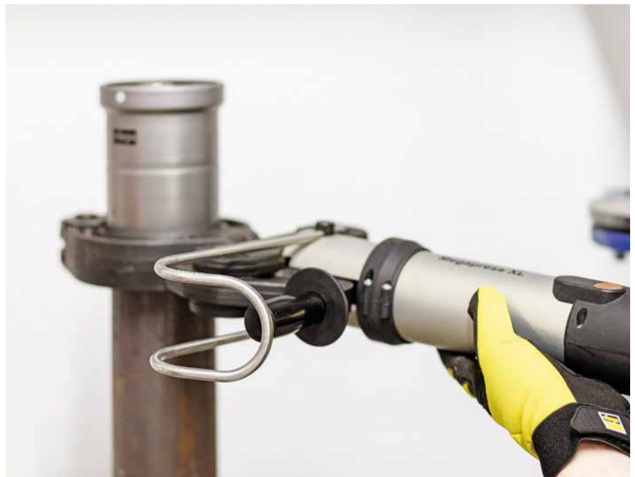
Die systemübergreifende „kalte“ Pressverbindungstechnik von Viega, hier mit dem „Pressgun-Press Booster“ an einem „Megapress S XL“-Verbinder, trug im Kotsch-Neubau „wesentlich zur wirtschaftlichen und sicheren, vor allem aber termintreuen Umsetzung der Installationen bei“, so SHK-Meister Marcus Schietzold.
