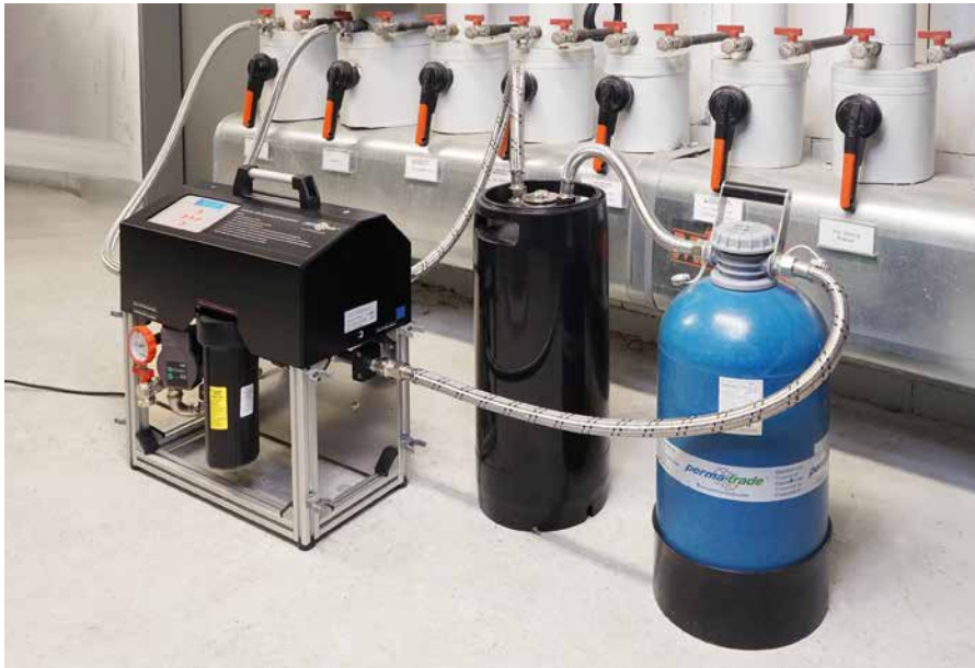
Bei der Aufbereitung von Anlagen im Teilstromverfahren sind aller guten Dinge drei: Das mobile Gerät permaLine, die Sauerstoffzehrpatrone OxRed PT-OR und die permasoft Entmineralisierungseinheit und arbeiten in Reihenschaltung.
