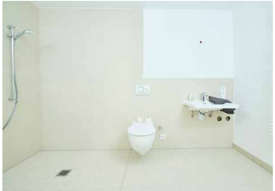
! Eine breite Schiebetür trennt das Bad vom Flur. Das Bild zeigt: Der Sanitärraum ist so bemessen, dass sich hier auch Personen mit Gehhilfe oder Rollstuhl bequem bewegen können.
