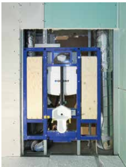
Hinter der Wand: Das Installationssystem Geberit Duofix verfügt über ein spezielles Element für barrierefreie WCs. Hier lassen sich später eine höhenverstellbare Toilette sowie Stützklappgriffe installieren.
