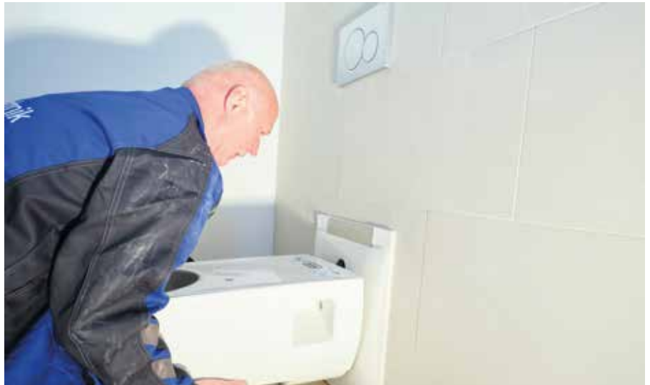
I Montage des Geberit Renova Comfort WCs: Gut zu erkennen ist die größere Ausladung der Keramik sowie der vormontierte Schallschutz zwischen WC und Wandfliesen.
