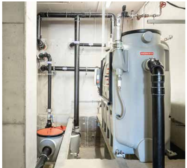
Ein Fettabscheider vom Typ ACO Haustechnik LipuJet-P-DAP NS 4 sowie eine Hebeanlage Multi Duo bewerkstelligen die vorschriftsmäßige Zuleitung der Abwässer in die Kanalisation.
