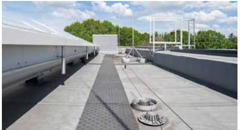
Zweiteilige Flachdachabläufe ACO Spin von ACO Haustechnik für norm- und fachgerechte Ableitung des anfallenden Regen und Schmelzwassers.
