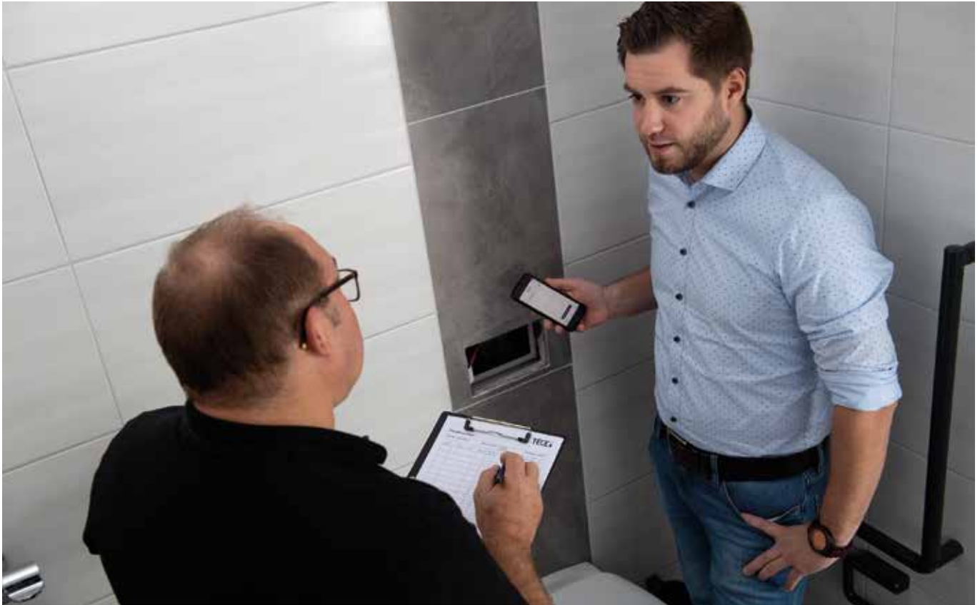
! Direkt vor Ort: Der TECE-Produktmanager Marius Leusing (rechts im Bild) bei der Inbetriebnahme der Hygienespülungen und Einweisung des Kunden.
